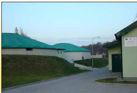
Oczyszczalnia ścieków w Miłakowie
