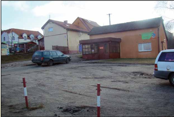
Parking ul. Swierczewskiego przez remontem
