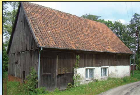
Świetlica w Starych Bolitach przed remontem
