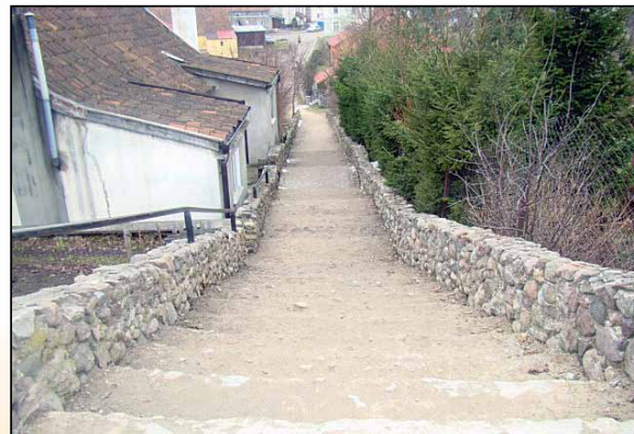
Schody przed modernizacją
